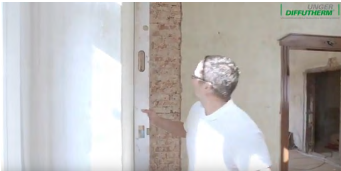
Contrôle du support et de sa planéité. ...
