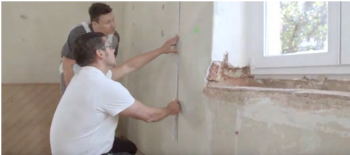
Calepinage pour une installation optimale : définir la répartition des panneaux.
