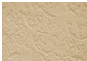
Structure enduit taloché
