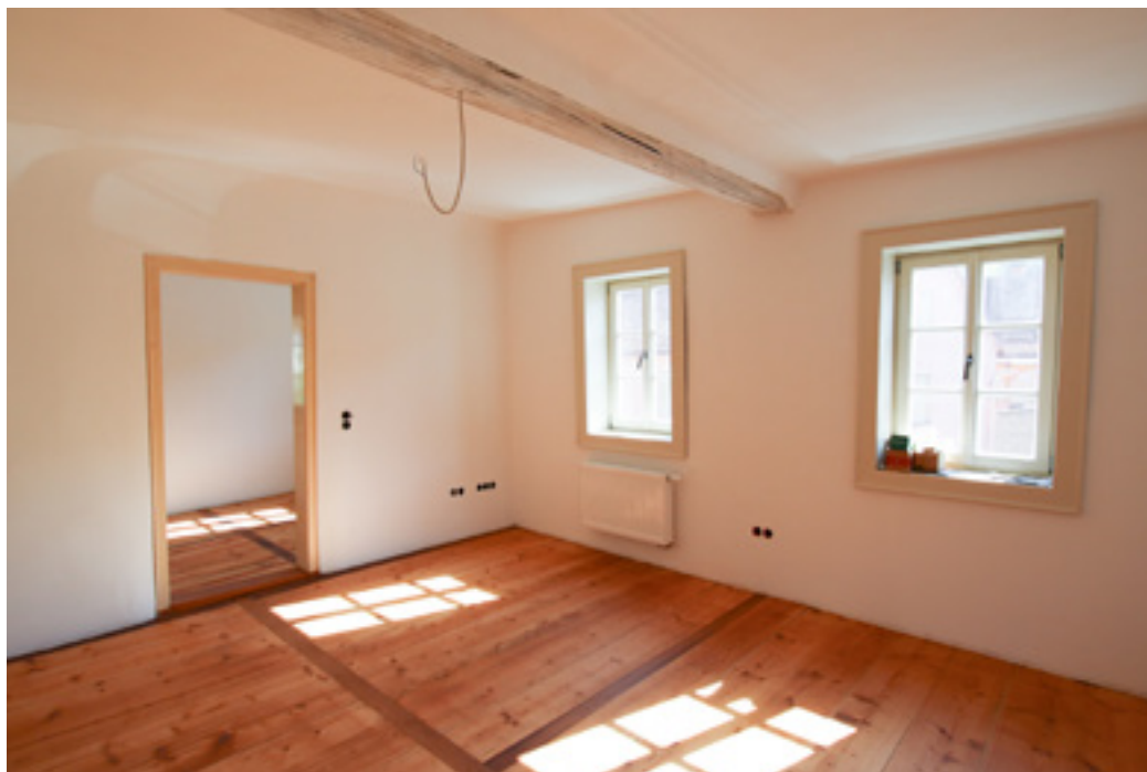
Photo : murs enduits avec UdiSIKATO®.
